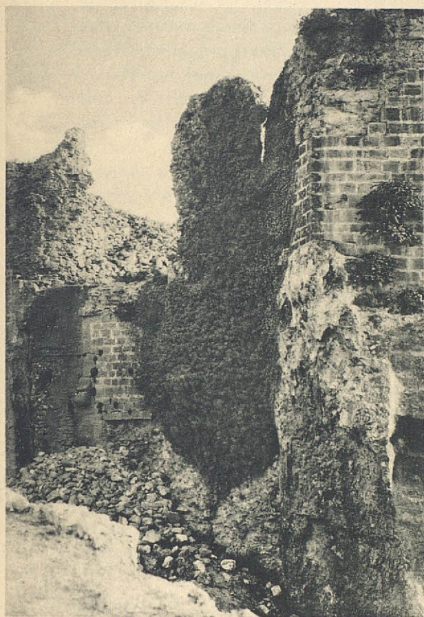
Foso del castillo que salvaba el puente de acceso, que se ha de reconstruir.
