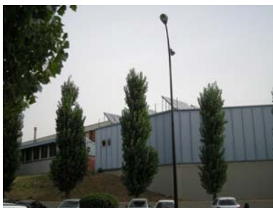
Instal·lació de col·lectors solars al sostre de les calderes del poliesportiu.
