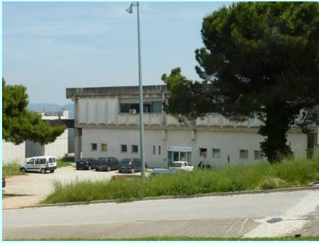
Imatge exterior de la UTPR.
