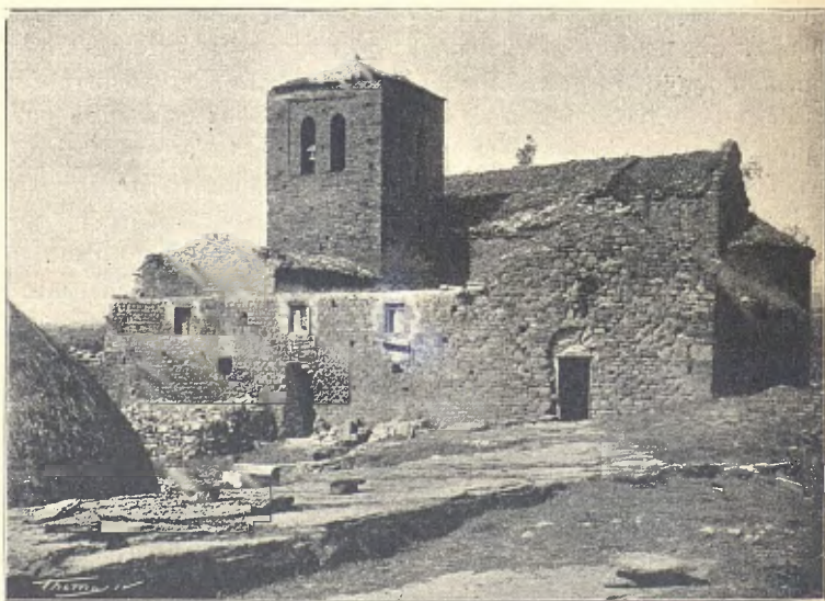
SANT PERE DE CASSERRES: VISTA EXTERIOR
