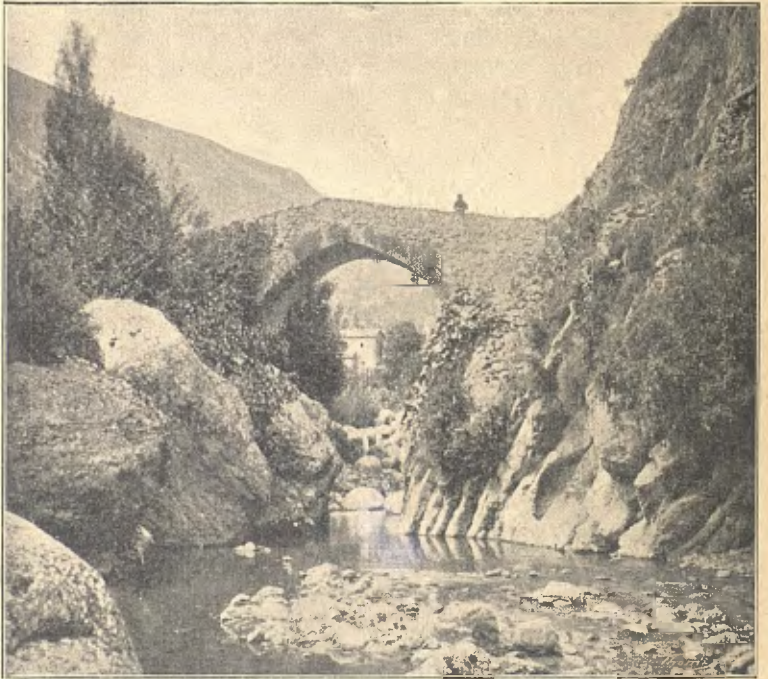
PONT DE ÇARROCA
