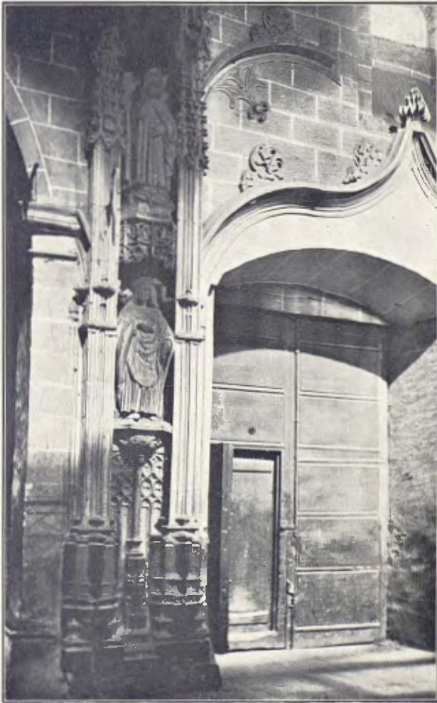
CATEDRAL : PORTAL D'ENTRADA AL CLAUSTRE
