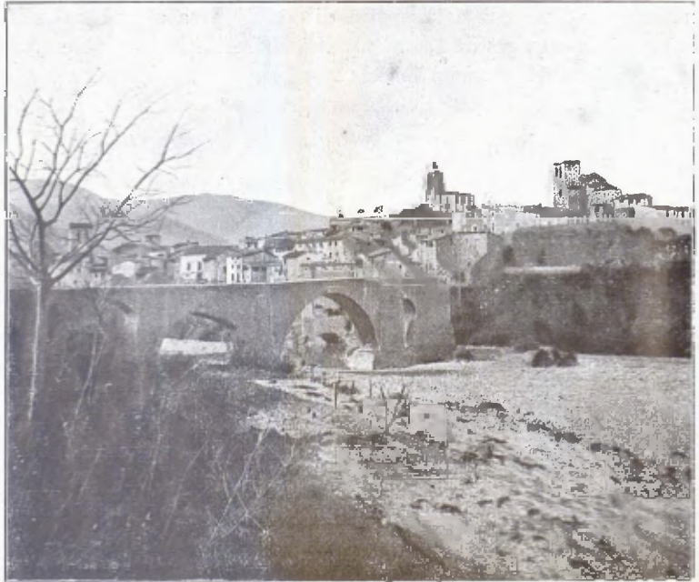
BESALÚ : VISTA GENERAL
