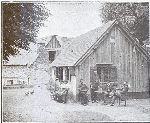
CANTINA DEL PORTILLÓ DE BOSSOST
