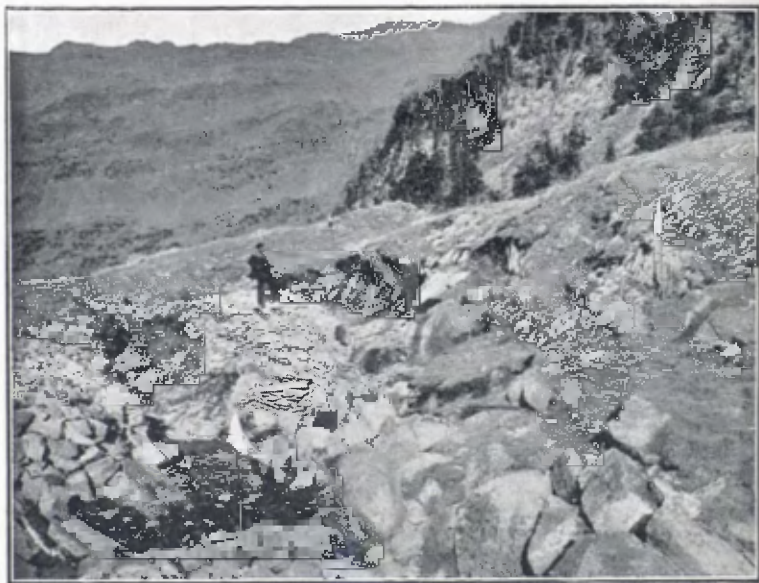
DESMUNTANT EL TERRER
