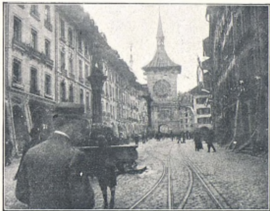
BERNA : TORRE DEL RELLOCTGE
