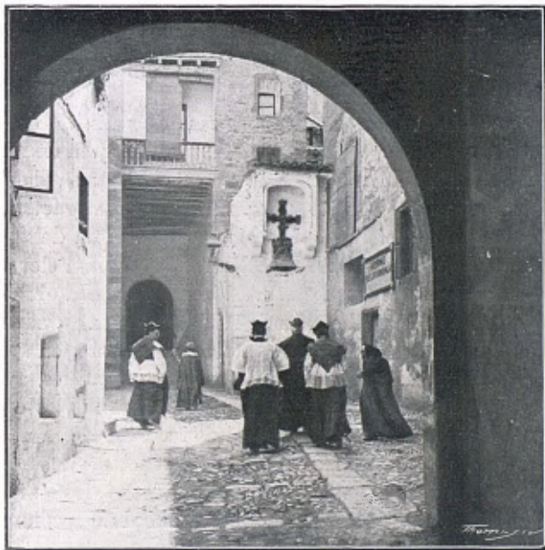
CARRERET DEL PALAU
