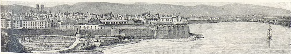
PORTAL DE SANTA MADRONA Y BALUART DE LAS PUSAS
