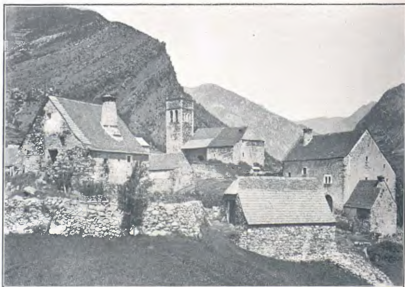
JAVIERRE : VISTA GENERAL
