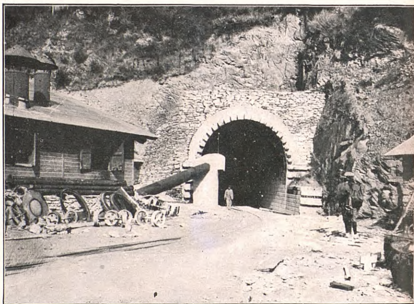
ENTRADA AL TÚNEL PER LA VALL DE RIBES
