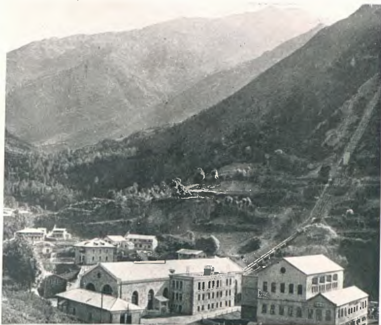
Capdella Central Elèctrica (pàg. 104)
