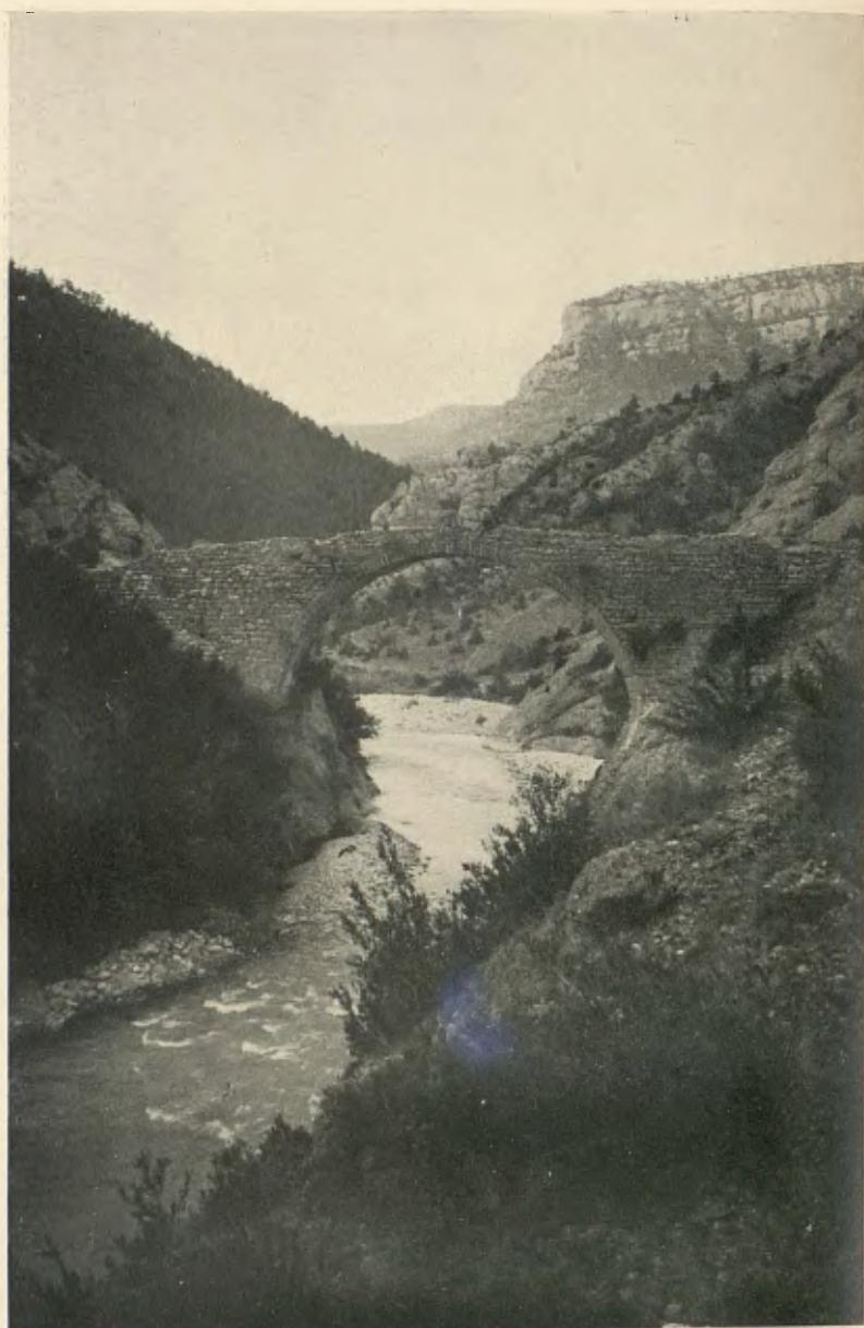
PONT DE VALLONGA SOBRE EL CARDENER
