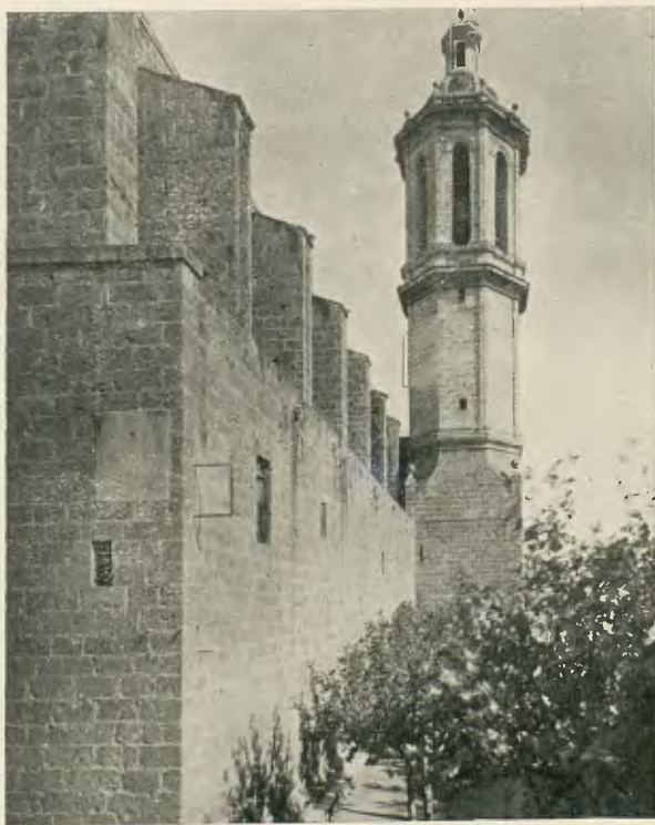
ESPARRAGUERA - CAMPANAR DE L'ESGLÉSIA DE STA. EULÀRIA
