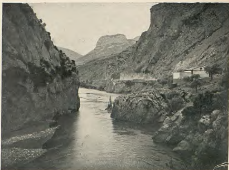
EL TOLL DE LA LLÚDRIGA EN L'ESTRET DELS TRES PONTS
