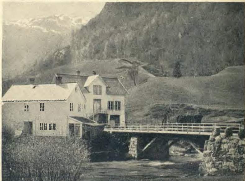
PONT D'ENTRADA A EIDE
