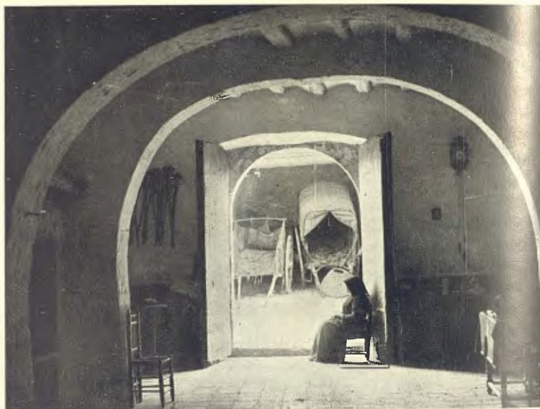
SANT CLIMENT DE LLOBREGAT (PLA DE LLOBREGAT). CAN RIERA VELL
