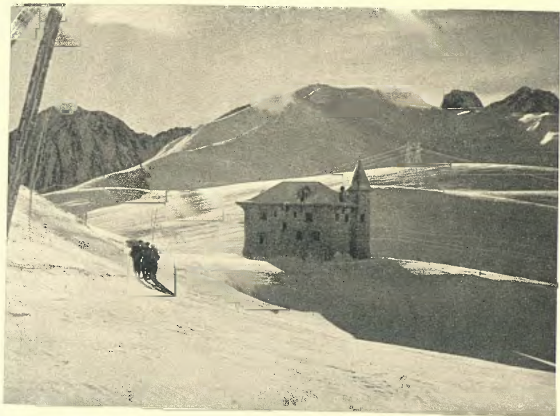
EL PORT DE LA BONAIGUA. XALET DE LA PRODUCTORA DE FORCES MOTRIUS PORT DE LA BONAIGUA I TUC DE CAMPO
