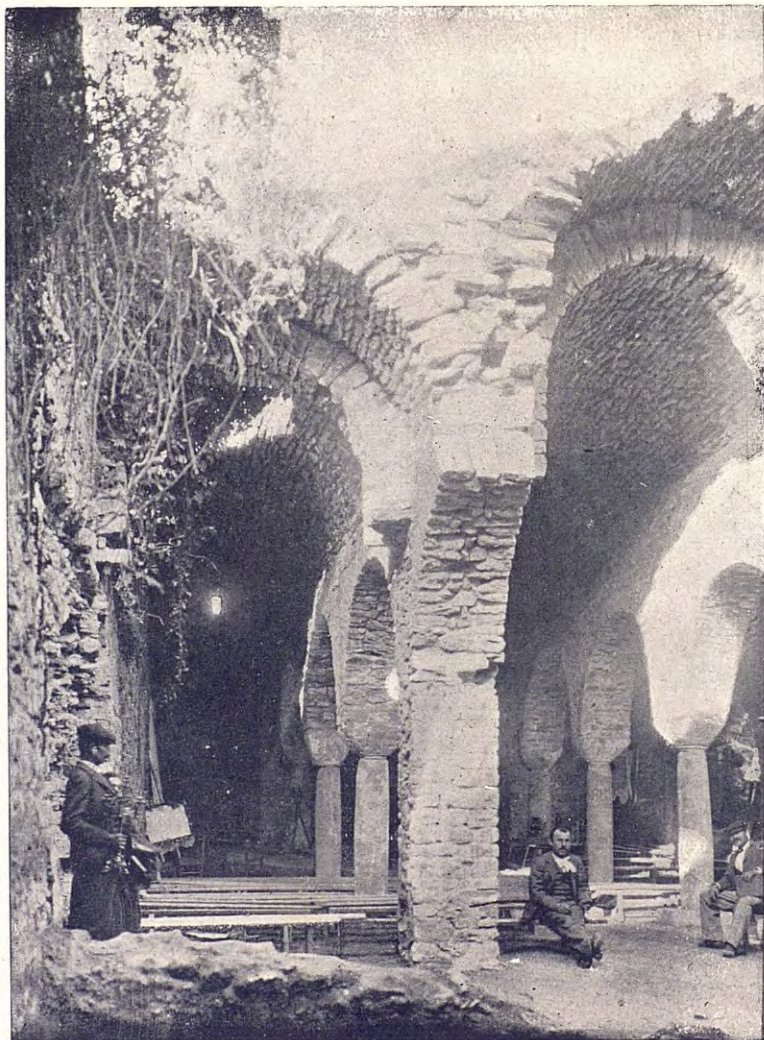
SANT MARTÍ DE CANIGÓ ABANS DE LA RESTAURACIÓ. FORMA DE CONSTRUCCIÓ EN LA QUAL LA VOLTA REPOSA SOBRE COLUMNES LOMBARDES
