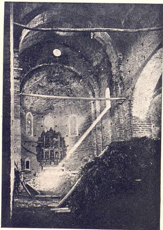
SANT PERE DE CASSERES, (GUILLERIES). NAU CENTRAL AMB VOLTA DE CANÓ
