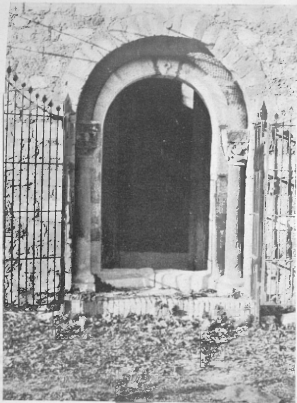
PORTA DE LA CAPELA DE LA VERGE DEL CAMÍ (LA GARRIGA)
