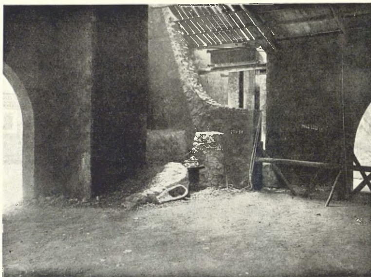
La farga de l'Exposició Nacional de Barcelona 1930. Recó on hi ha el fossat o carrall. Darrera es veu la trompa i, apoiats al fossat o carrall i parets, un mall i les tenalles de agafar l'acer autèntics. El fons no té xemeneia. Per l'espai obert del sostre entra un raig de sol, tal com a voltes entrava a les fargues autèntiques
