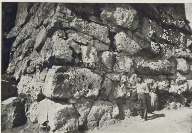
Aparell megalític de la torre de Sant Mugi. A l'angle de l'esquerra, a dalt, dos caps esbossats. Alçada: 6'50 metres
