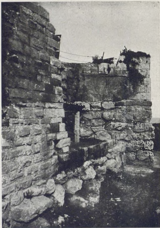
Consolidació de la muralla i torre de Sant Magi. Un cobert protegeix un massís de tones de l'estructura interior
