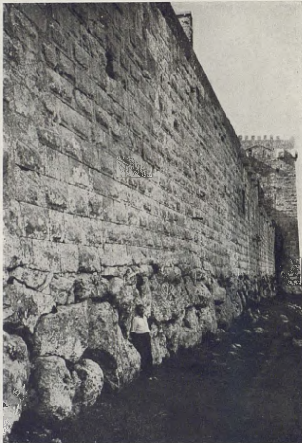
Muralla amb la torre del Pavorde, avui anomenada de l'Arquebisbe, al fons. L'aparell inferior s'eleva a 2'40 metres; l'obra romana fins a 11 metres
