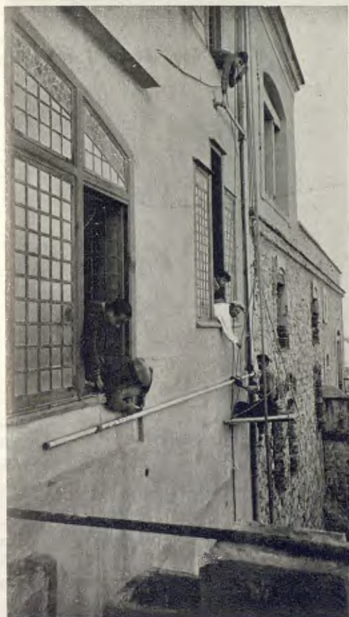
Col·locació dels tubs conductors de l'aigua per al servei contra incendis, al terrat i a les façanes posterior i principal de l'edifici del «Cau Ferrat»
