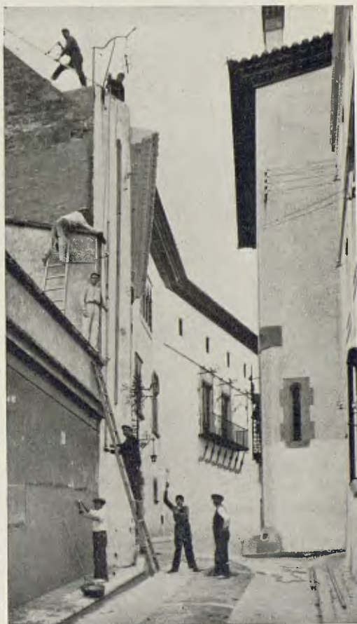
Col·locació dels tubs conductors de l'aigua per al servei contra incendis, al terrat i a les façanes posterior i principal de l'edifici del «Cau Ferrat»
