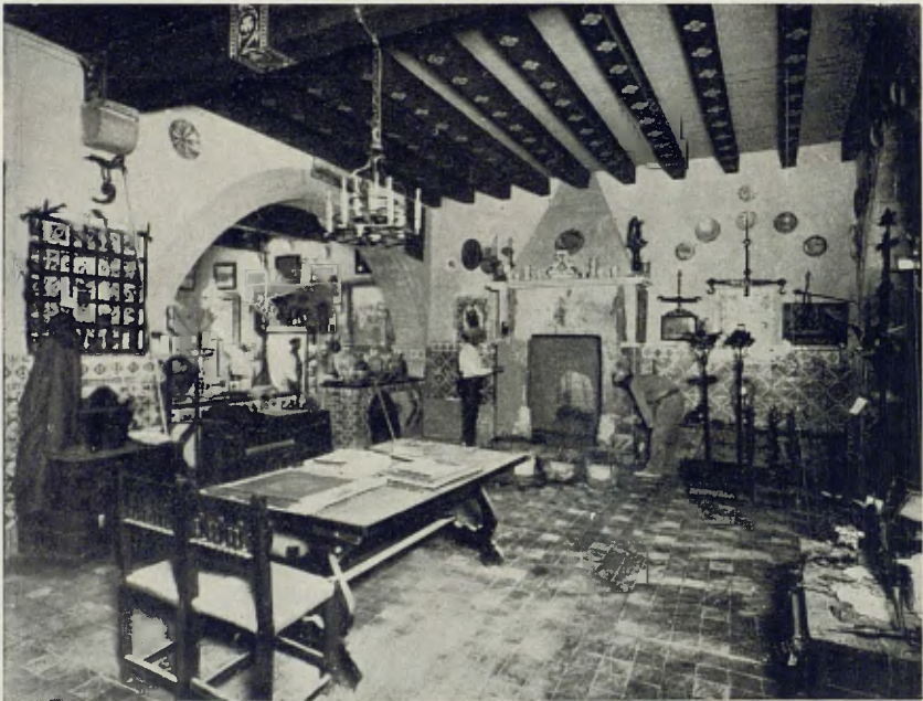
Obres de reparació en una de les llars de foc del «Cau Ferrat»
