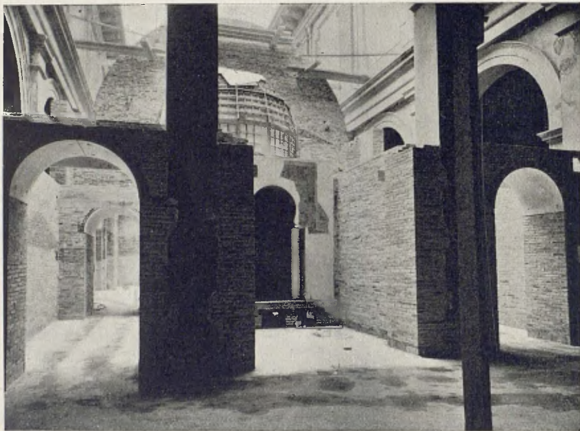
La construcció del vestibul on hi ha l'absis de Pedret
