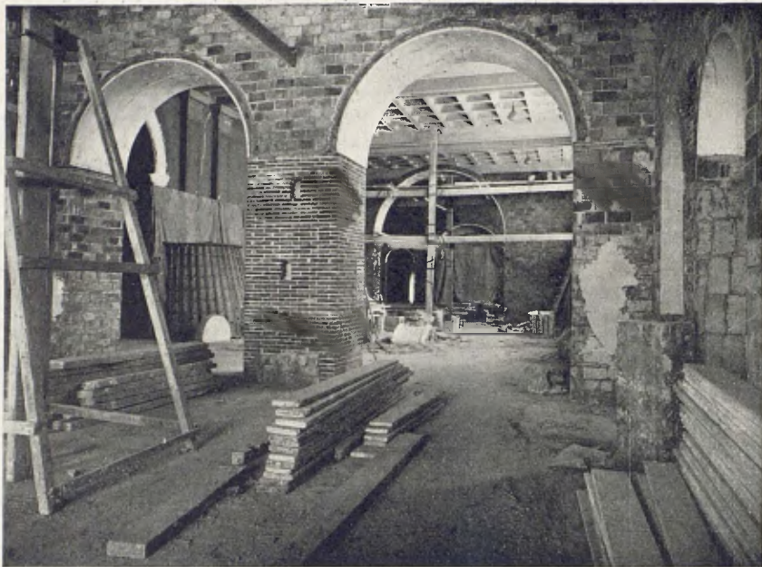
Sala de les pedres i dels frontals de la fi del segle XII
