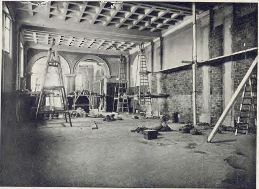
La construcció d'embans aïllants en una de les sales del Palau Nacional
