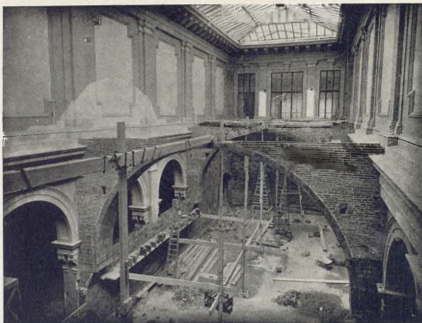
Construcció de les arcades de la sala de la fi del segle XV
