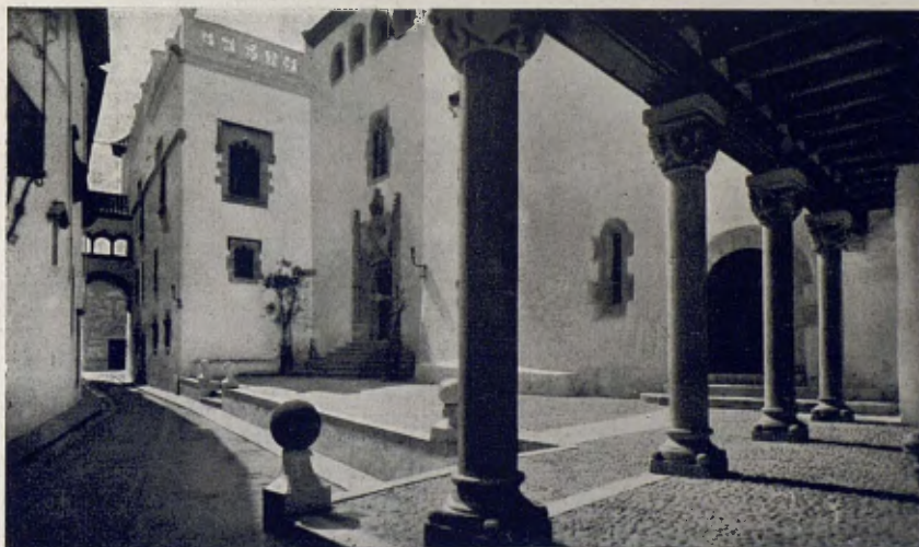
Façana principal de la part de «Maricel» que és destinada a ampliació del «Cau Ferrat»
