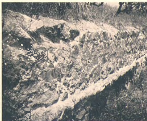
Fig. 4. — La gran paret (a' a'' del plànol). Aquesta paret té les següents mides: alt aparent, 1,25 m.; llarg, 15,00 m.; gruix, 0,45 a 0,60 m.
