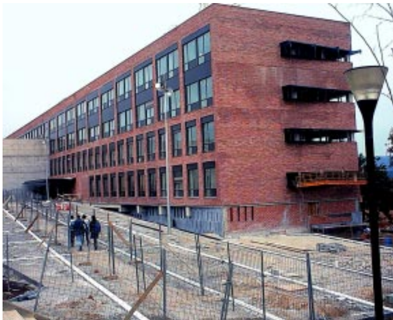
Les enginyeries de la UAB tindran un nou edifici.
