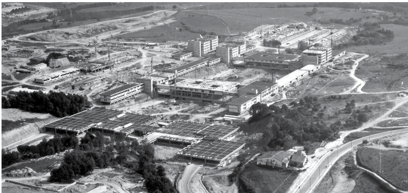
Vista general de les obres de construcció del campus de la UAB a Bellaterra (Cerdanyola del Vallès).
