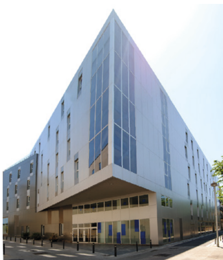
Fig. 2. Edifici actual del Conservatori Superior de Música del Liceu al barri del Raval de Barcelona.
