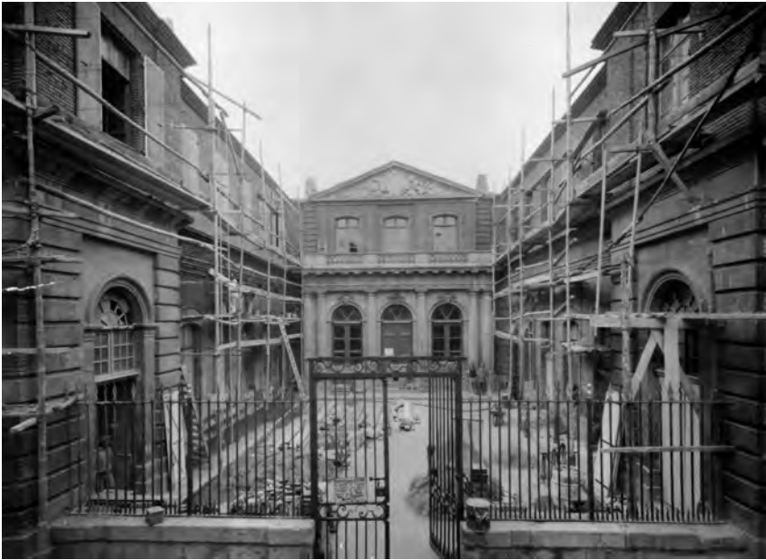
FIGURA 6. Fotografia de la campanya d'obres de restauració i de modernització de l'edifici de l'antiga Universitat de Perpinyà, 1952. © Col·lecció particular, Perpinyà.
