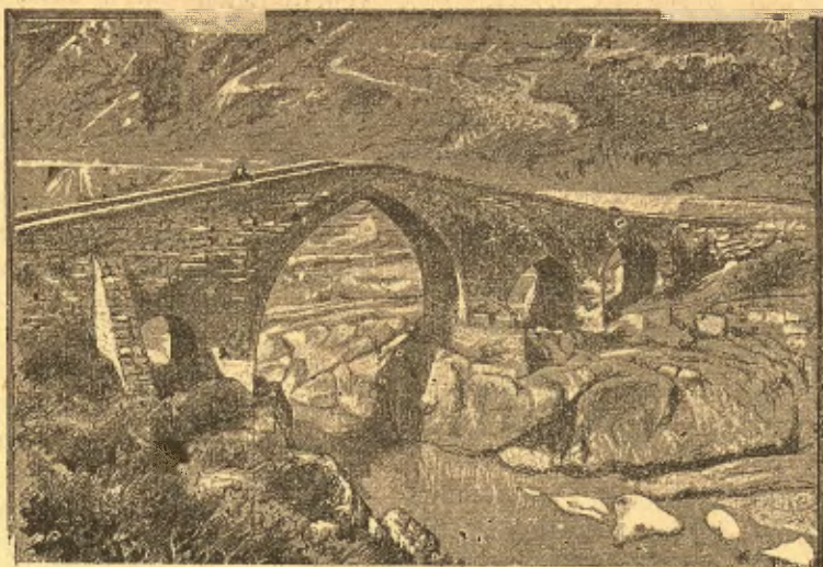
Pont de Pedret, proper á Berga
