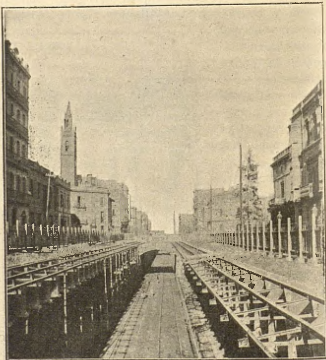
LAS OBRAS DEL PUJADOR DEL CARRER D'ARAGÓ. TROS COMPRÉS DEL CARRER DE CLARÍS AL DE LAURIA. (Fot. de A. Culilla Gil).
