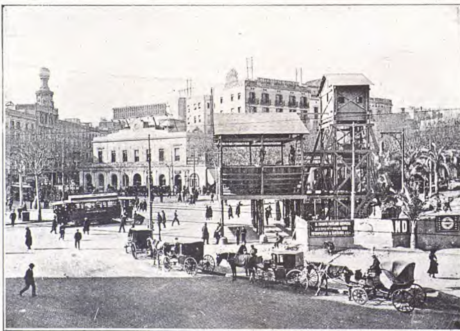
Estació del Ferrocarril de Catalunya, coneguda per l'Estació de Sarrià i les obres del Metropolità
