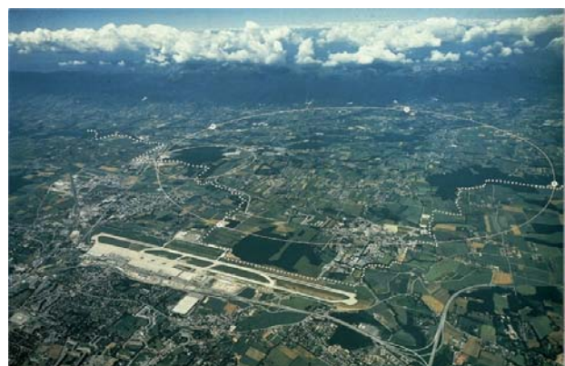
Figura 2. A dalt, edificis del CERN. A sota, localització del túnel subterrani del LEP a les rodalies de Ginebra. Les rodonetes blanques indiquen la posició dels grans detectors, i la línia de punts, la frontera franco-suïssa.
