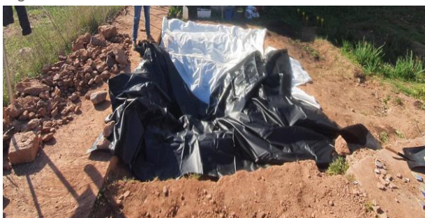
Figura 8. Impermeabilització de la bassa.
