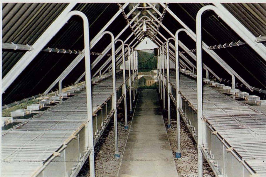
Interior de una instalación "Cunair" en la que se aprecian los detalles estructurales.
