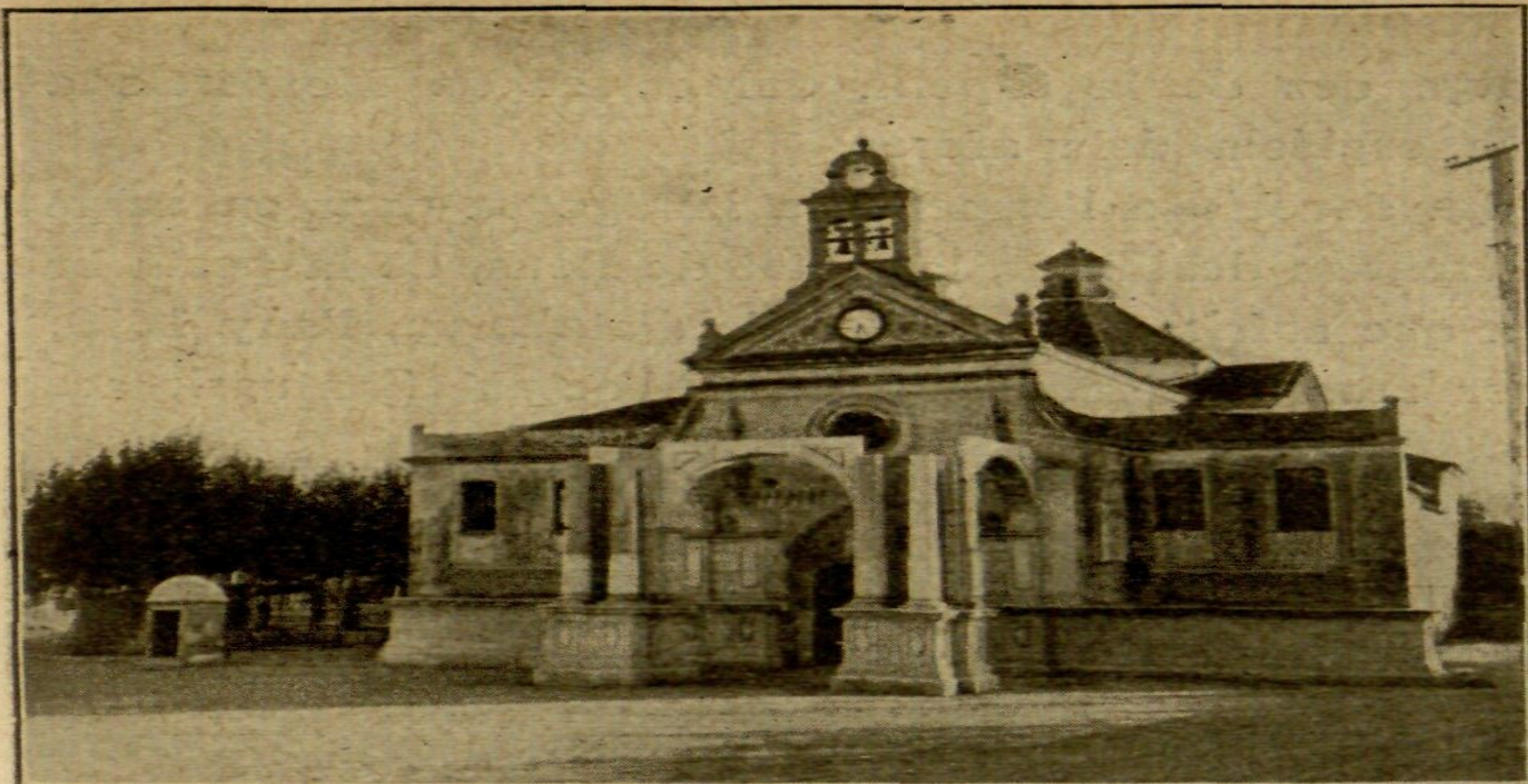
Façana principal, en construcció, del Santuari de la Mare de Déu de la Misericòrdia.
