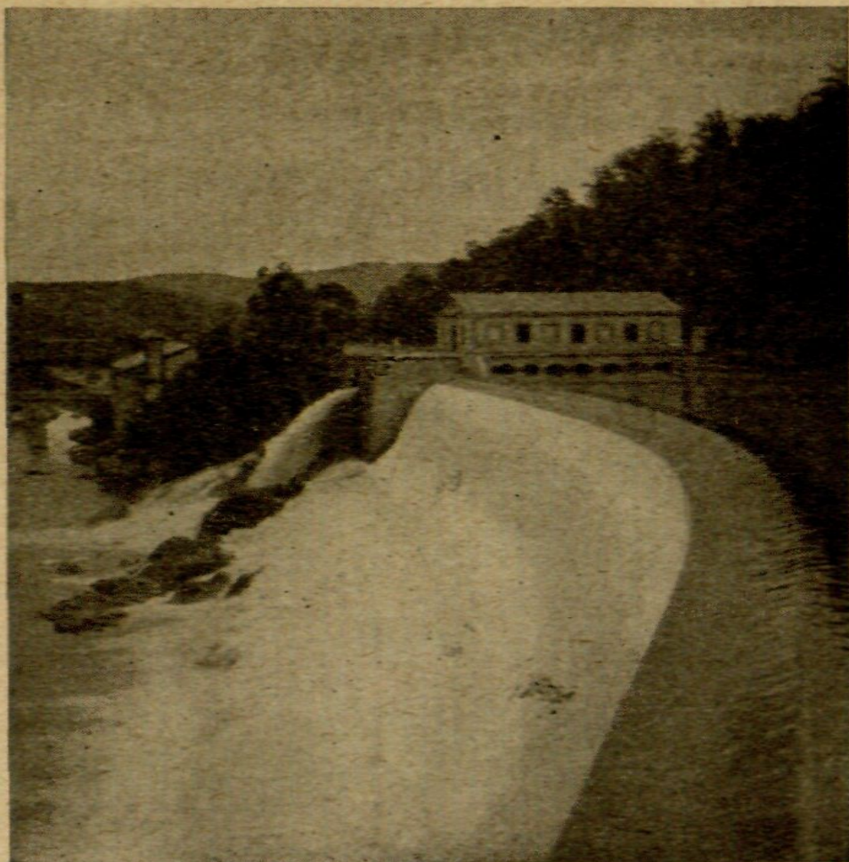
El Pasteral. - Vista de la presa i central elèctrica.
