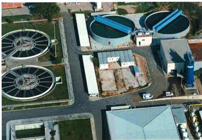
Vista general de la planta de fangs de la ETAP Llobregat
