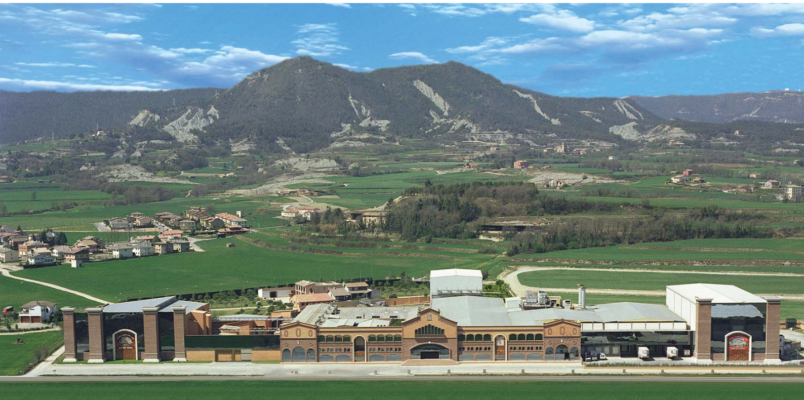
Vista general de les instal·lacions de Casa Tarradellas a Gurb
