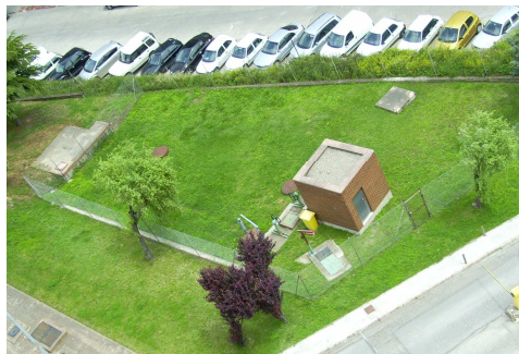
Imatge 2. Depuradora CHV
