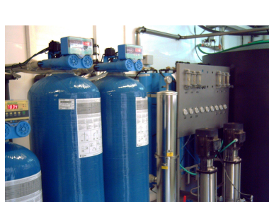
Imatge 3. Planta d'aigües d'hemodiàlisi
