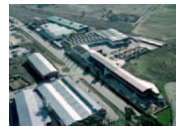
Griñón construïts Madrid 7.250 m 2 Cel·les secundàries i centres prefabricats de formigó
