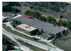
Puente la Reina construïts Navarra 8.000 m 2 Petit material elèctric
