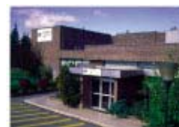
Burlada construïts Navarra 11.500 m 2 Components de control industrial
