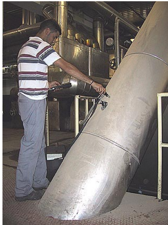
Control emissions focus F24 caldera de fluid tèrmic
