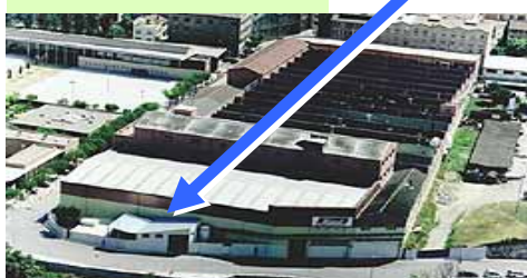
Estació depuradora d'aigües residuals industrials
