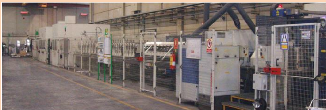
Línia de mecanitzat, perfilat i soldadura dels muntants SF
