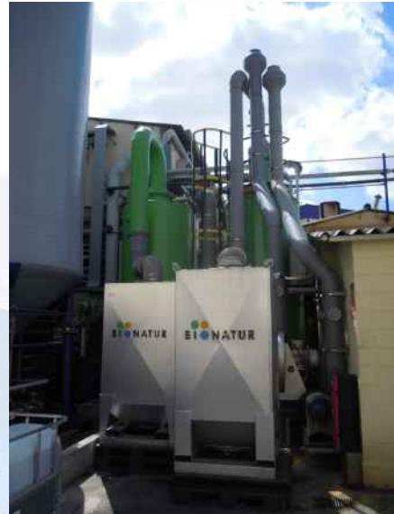
Por otro lado, a finales de 2018 se instaló un pequeño filtro de carbón activo en la nave de resinas que nos permite captar las puntuales emisiones acrilonitrilo que se generan cuando se realizan pesadas de este compuesto en las básculas de la planta.
