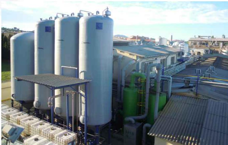
En el año 2014 decidimos automatizar el control de los niveles de los tanques de producto acabado de floculantes. El proyecto consistió en instalar células de pesaje para cada uno de los 7 tanques.
