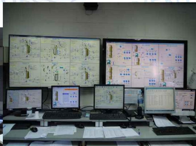
Dos pantallas de 50 pulgadas que permiten; visualizar simultáneamente 6 procesos diferentes incrementando así la capacidad de control y de reacción de los encargados de planta, y por otro lado, monitorizar diversos tanques de materias primas y la instalación del mezclador M5.
