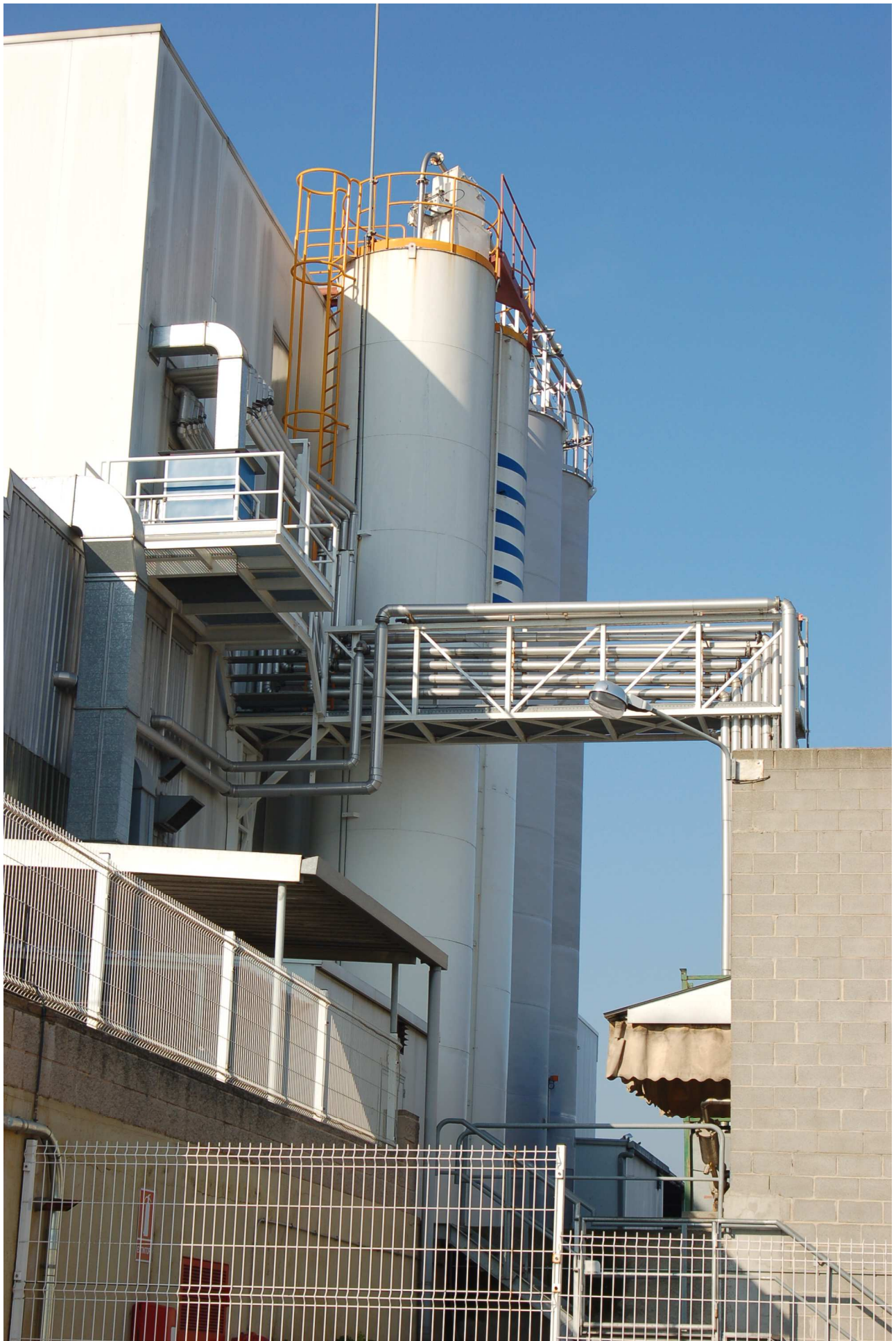
Silos de almacenamiento de cargas minerales.
