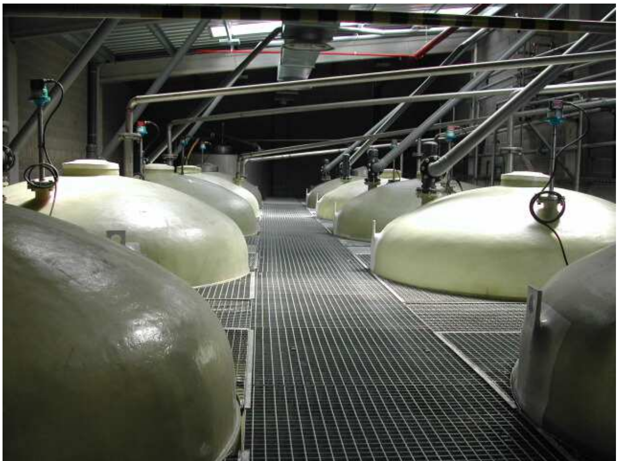
El almacén de Resinas dispone de un sistema automático de detección y extinción de incendios por espuma. La parte inferior del almacén es en si misma un cubeto de retención en caso de fuga.
